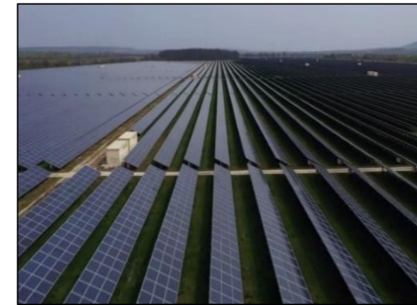
Figure 8 : Photographie du parc photovoltaïque "Karad" – Bulgarie
